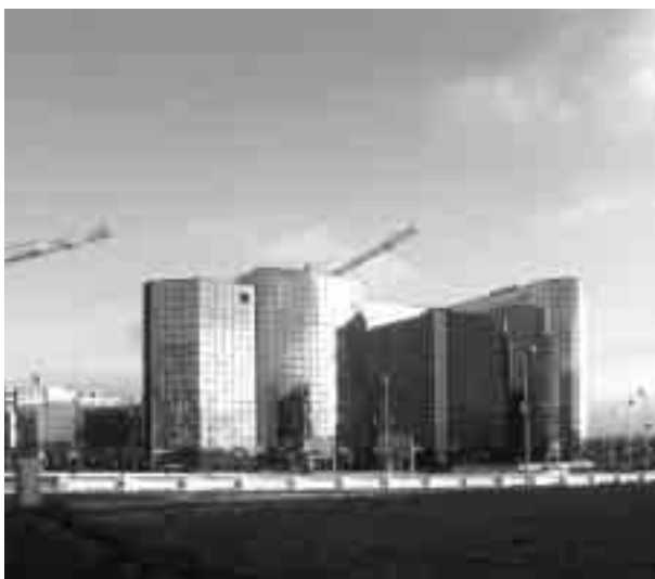
Bureaux en construction à Noisy-le-Grand, Marne-la-Vallée
